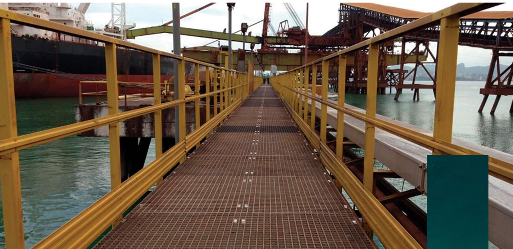
As grades de piso em COMPÓSITOS atendem as normas da ASTM F3059-18 em level 2 e 3, e conforme a Norma ABNT NBR 15708-3.
